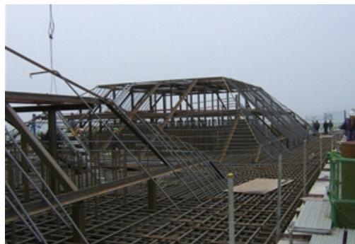
> Pedestal 철근받침 설치
